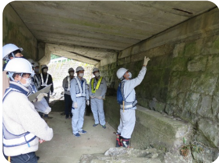
橋梁点検の様子
