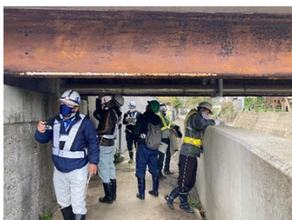
橋梁点検実習
