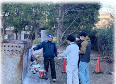
コンクリート構造の点検演習
