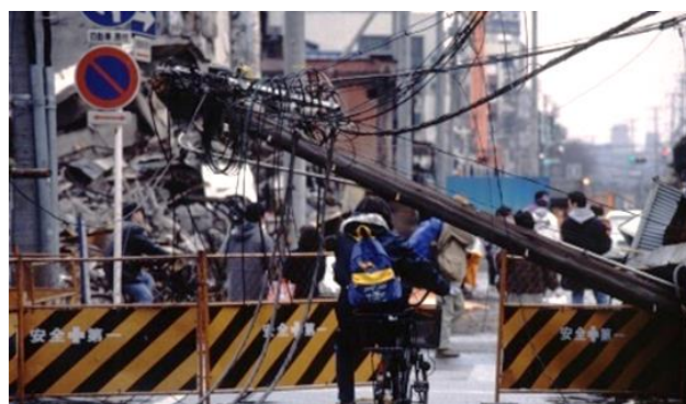
地震による電柱倒壊（神戸市長田区）
