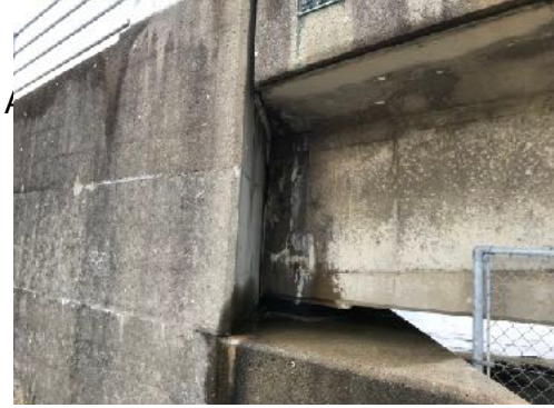
A2 桁端部 (写真-7)
