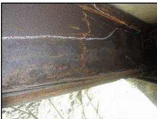
主桁の腐食
