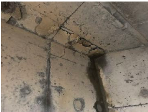
A2 桁端部 (写真-8)
