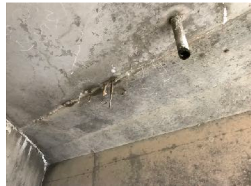
A2 桁端部 (写真-9)
