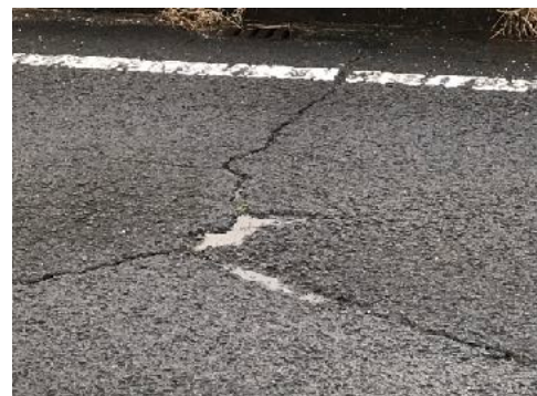
橋面（2径間目）拡大写真（写真-5）
