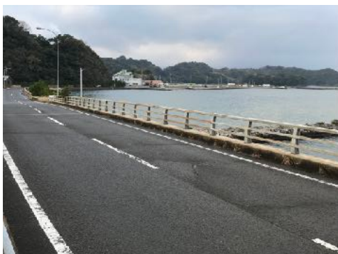
橋面（2径間目）（写真-4）
