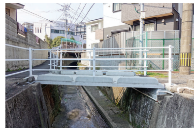
供用状況（橋軸直角方向）
