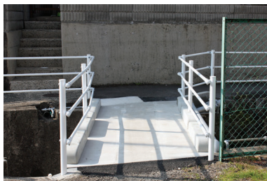
供用状況（橋軸方向）
