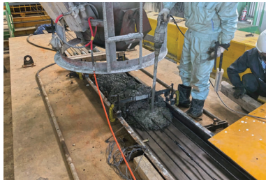
コンクリート打設
