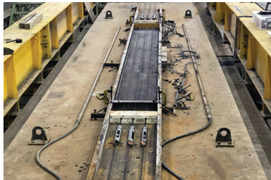
型枠へのケーブル配置
