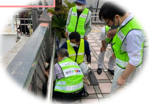
設置中の様子
