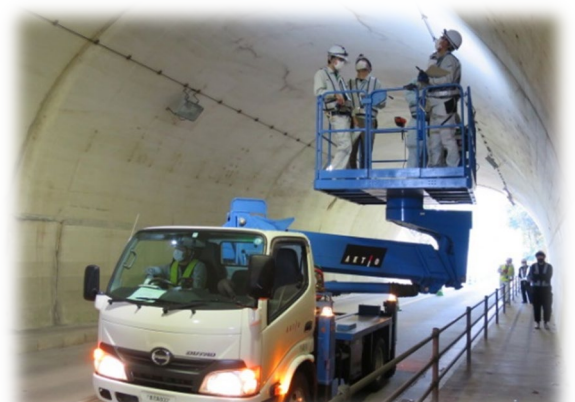
特定道守：トンネル点検
