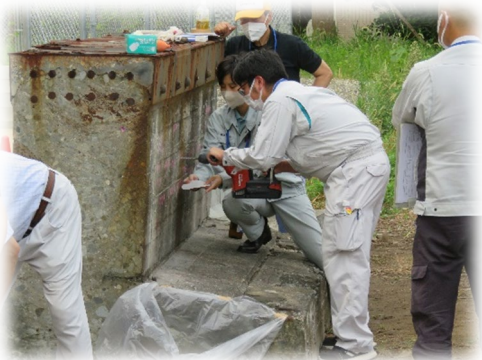
道守補：コンクリート演習
