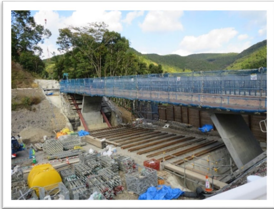
付替道落2号跨道橋
